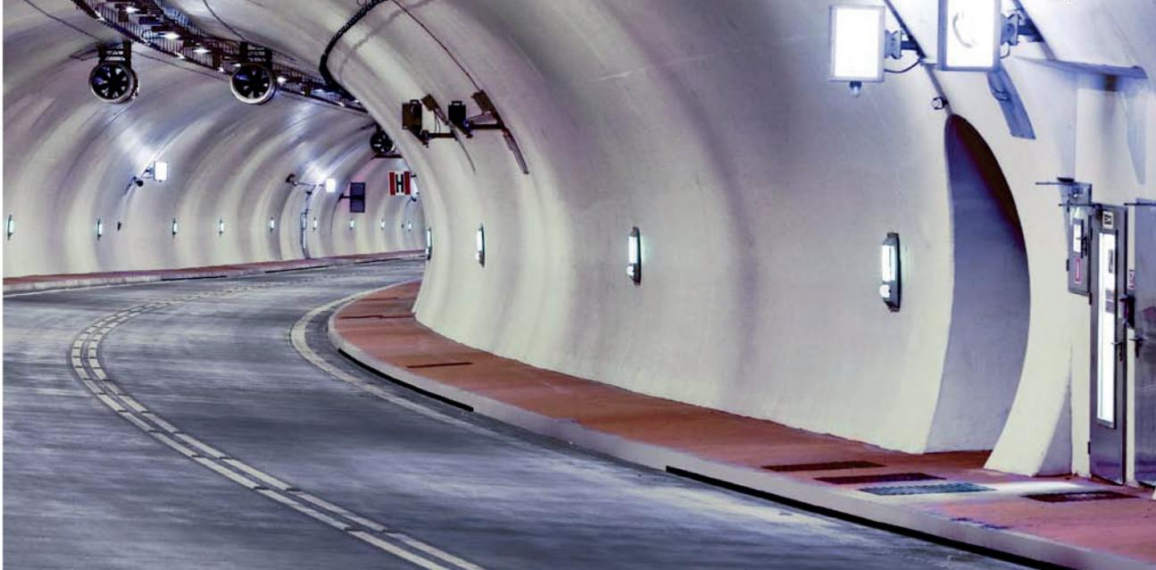
I canali del tunnel sono montati lungo la strada in una zona di cordolo e sono conformi al carico del C250. La forza classifica il prodotto come canale di tipo "I", cioè non richiede un grembiule di cemento.
