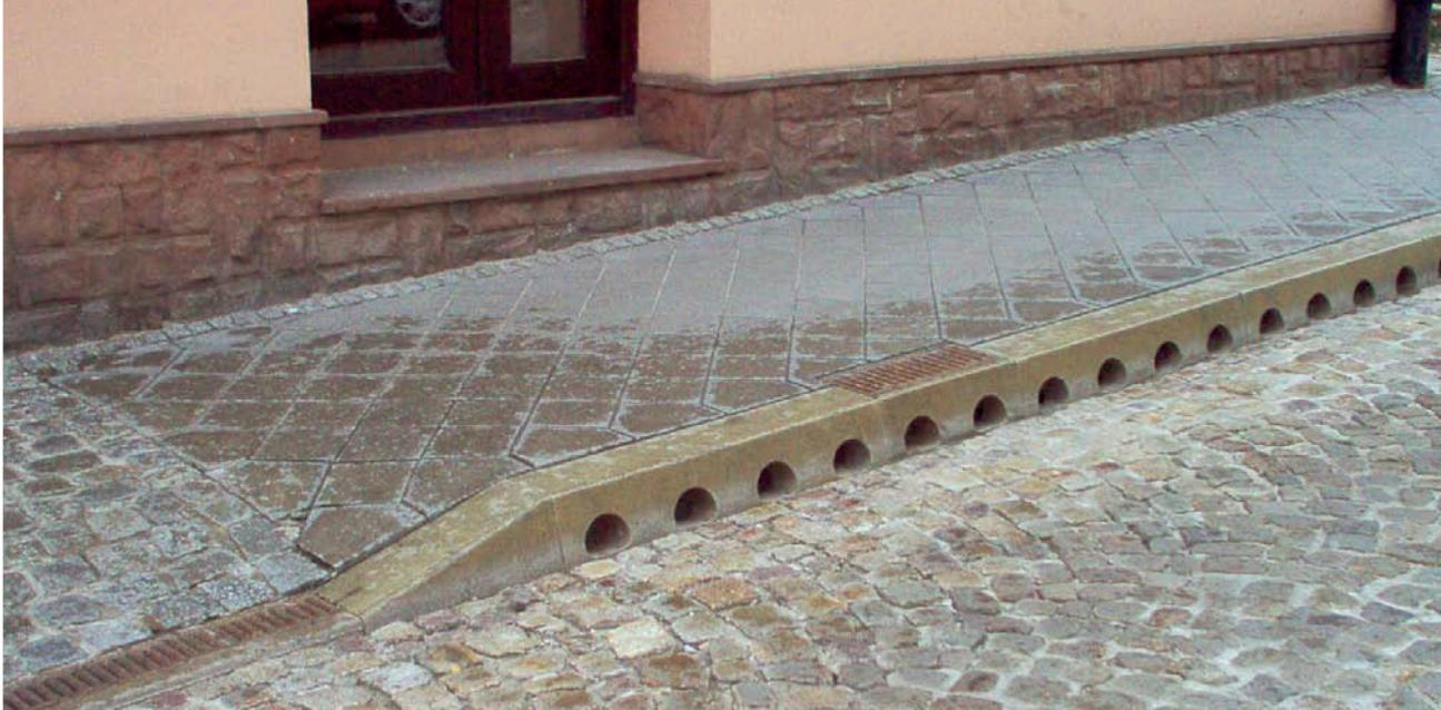
Destinato come drenaggio continuo o locale. Il drenaggio locale include un set di drenaggi di KKP all'esterno del pozzo di drenaggio.
