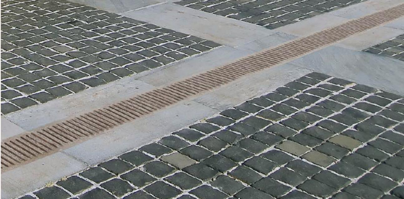
Per le camere di ispezione e i pozzetti di drenaggio, le griglie in ghisa vengono fissate con il bloccaggio del fermo su profili in ghisa.
