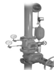
**IMPIANTO A UMIDO** - è normalmente installato in tutte le aree non soggette a rischio di gelo. Il principio di funzionamento è semplicissimo, la valvola di allarme a umido funziona come una normale valvola di ritegno con la capacità di generare allarmi nel momento in cui si attiva il sistema Sprinkler. Il sistema prevede una valvola di controllo, allarme ad umido e campana idraulica di allarme. Diametri gruppo di allarme da 3" - 4" - 6" - 8"
